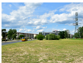
Budowa trasy tramwajowej na NOWODWORY
