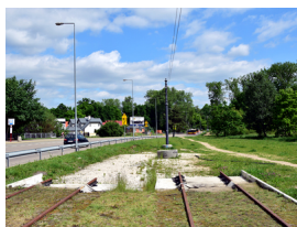
Budowa trasy tramwajowej na WINNICE
