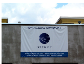
Budowa trasy tramwajowej na TARCHOMIN
