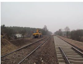
Budowa przystanku osobowego WARSZAWA MOKRY ŁUG
